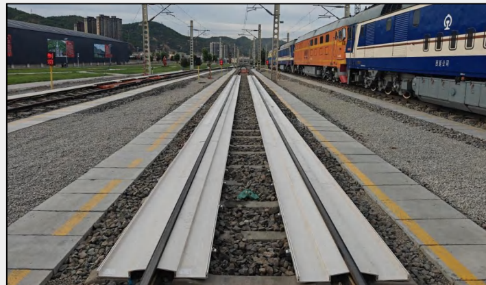
接砂槽安装案例
